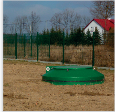
EKOFINN-POL, Oczyszczalnia ścieków BIOCLERE® dla budynku w Jeżewie Starym (woj. podlaskie). RLM: 20. Zastosowane urządzenia: osadnik wstępny, złożo biologiczne BIOCLERE® typ B22B, 2009.
