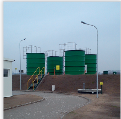
EKOFINN-POL, Oczyszczalnia ścieków BIOCLERE® dla miejscowości Rakutowo (woj. kujawsko-pomorskie). RLM: 750. Zastosowane urządzenia: osadnik wstępny OW36 x 2, złożo biologiczne BIOCLERE® typ B210 x 4, 2013.
