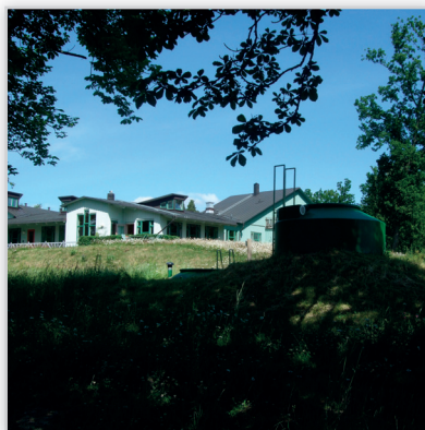
EKOFINN-POL, Oczyszczalnia ścieków BIOCLERE® dla osiedla domów (Skillebyholm, Szwecja). RLM: 70. Zastosowane urządzenia: osadnik wstępny, złożo biologiczne BIOCLERE® typ B75, stopień chemiczny BIOCLERE® typ K2.3, 2006.
